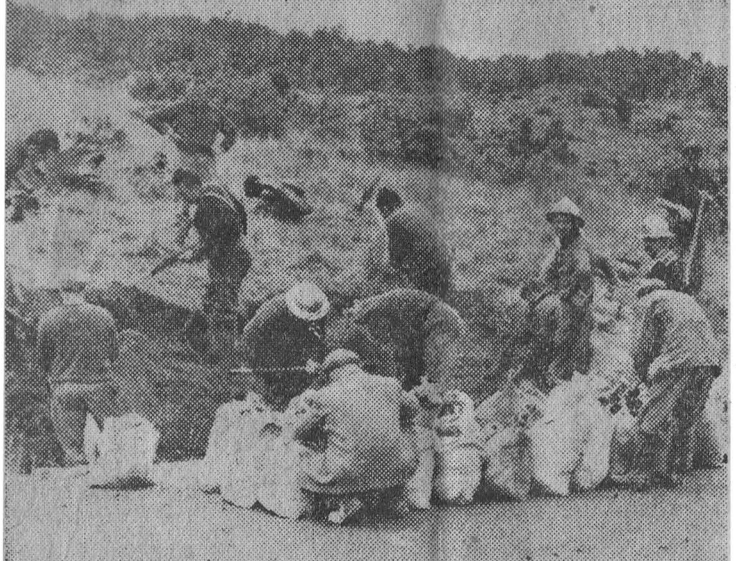
Ces sacs de sable que l'on empile sans désemparer parviendront-ils à retenir le cours de la rivière. (Photo A.B.)
